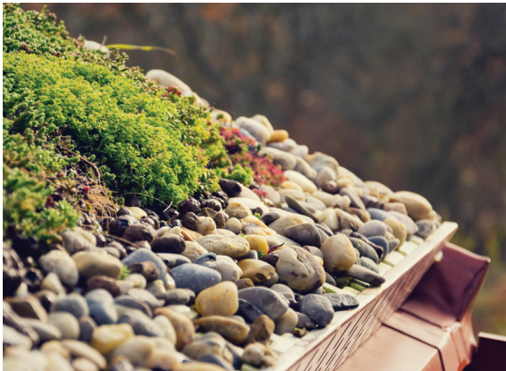
» Extensive Dachbegrünung im Schrägdach..
