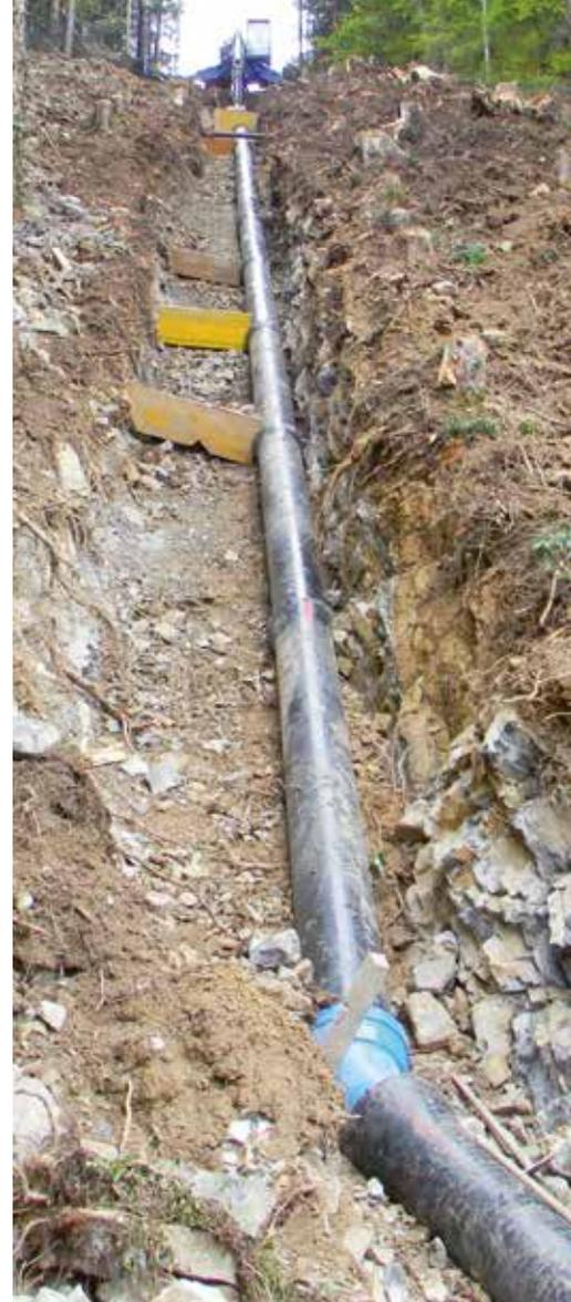
Im Druckrohr „schießt“ das Wasser Richtung K
