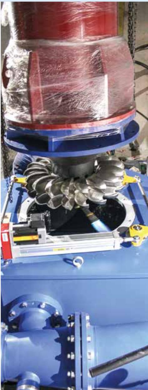
Das Schaufelrad der Turbine ist mit dem darüberliegenden Generator verbunden.
