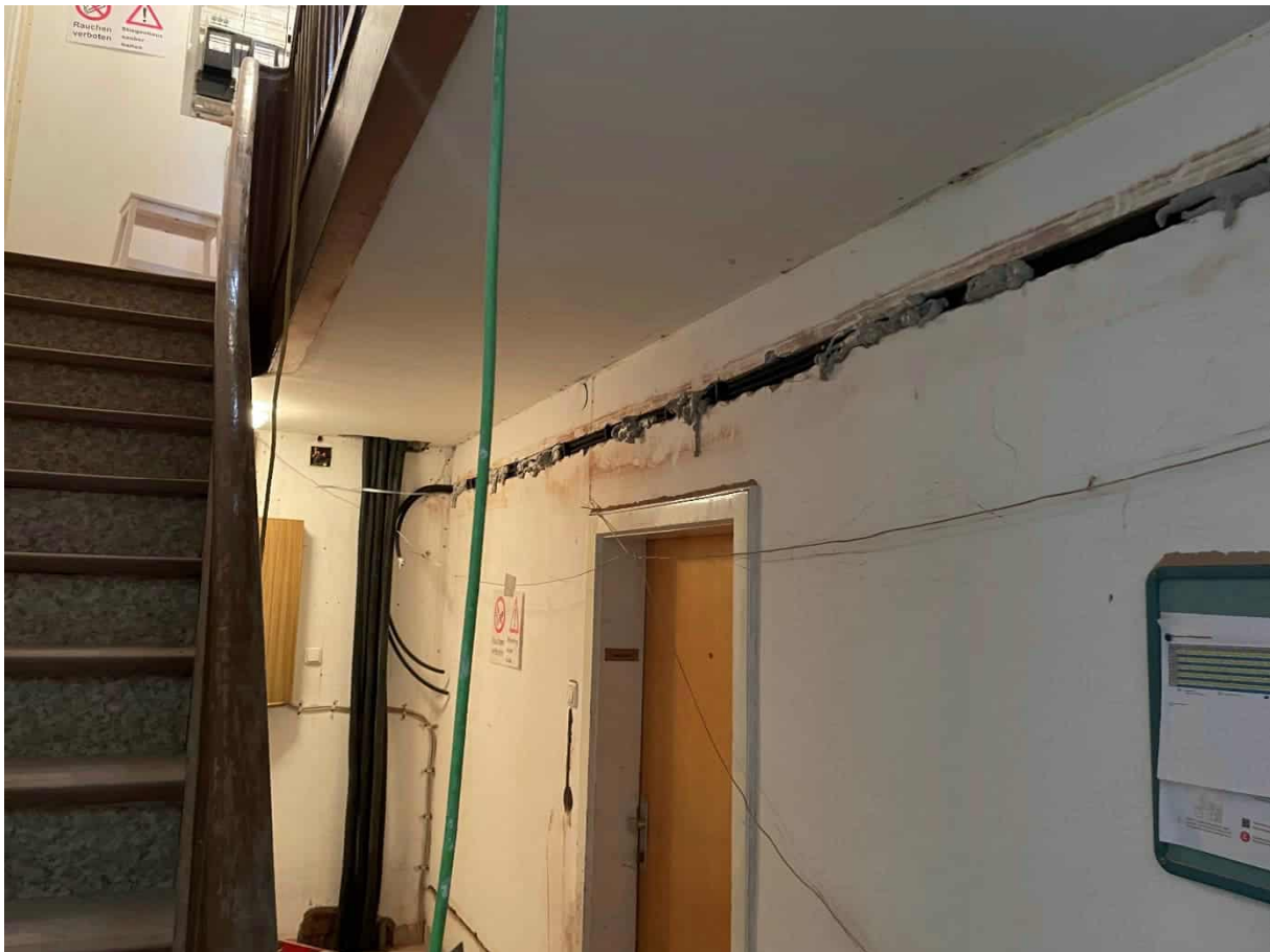
Abbildung 182: kleines Gebäude: Treppenhaus während der Sanierung; Foto: Rhomberg Bau GmbH
