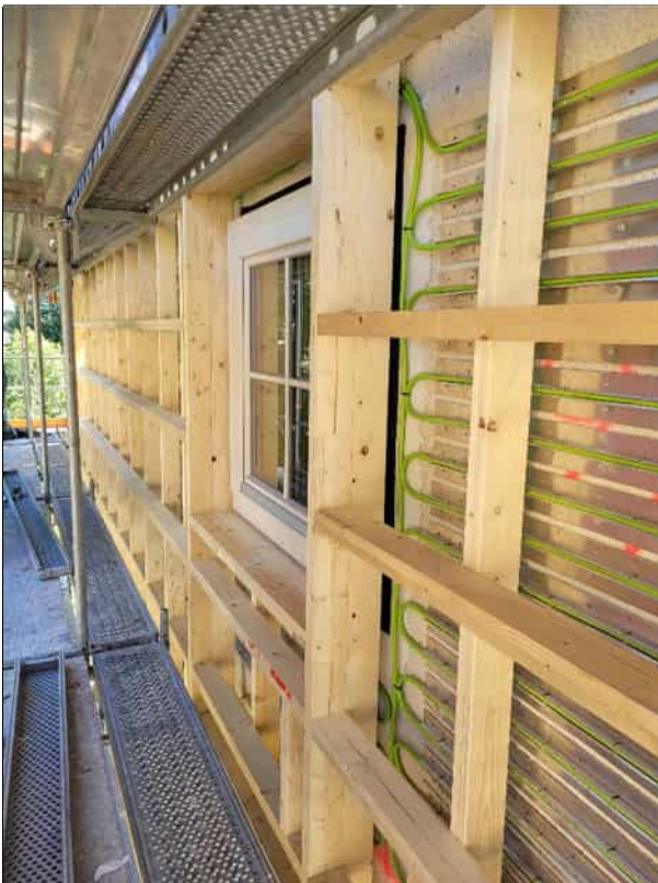
Abbildung 110: großes Gebäude: vorgefertigte Kreuzlagenelemente; Fotos: Energieinstitut Vorarlberg
