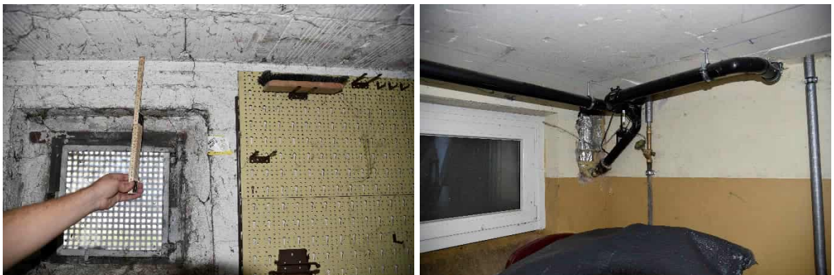
Abbildung 42: Kellerfenster und Kellerdecke, Fotos: Rhomberg Bau GmbH
