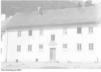
FENSTER ERRICHTUNG 1950 2 Flügel mit Sprossen
