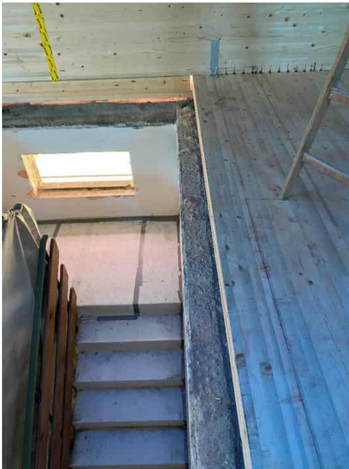
Abbildung 119: Neue lastabtragende BSH-Massivholzdecke im DG des großen Gebäudes; Foto: Rhomberg Bau GmbH
