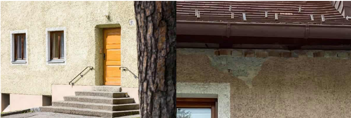
Abbildung 46: Status Quo der oberirdischen Außenwände im kleinen Gebäude – links, Foto Walser Fotografie, Hohenems und in einem weiteren Gebäude, Foto: Energieinstitut Vorarlberg
