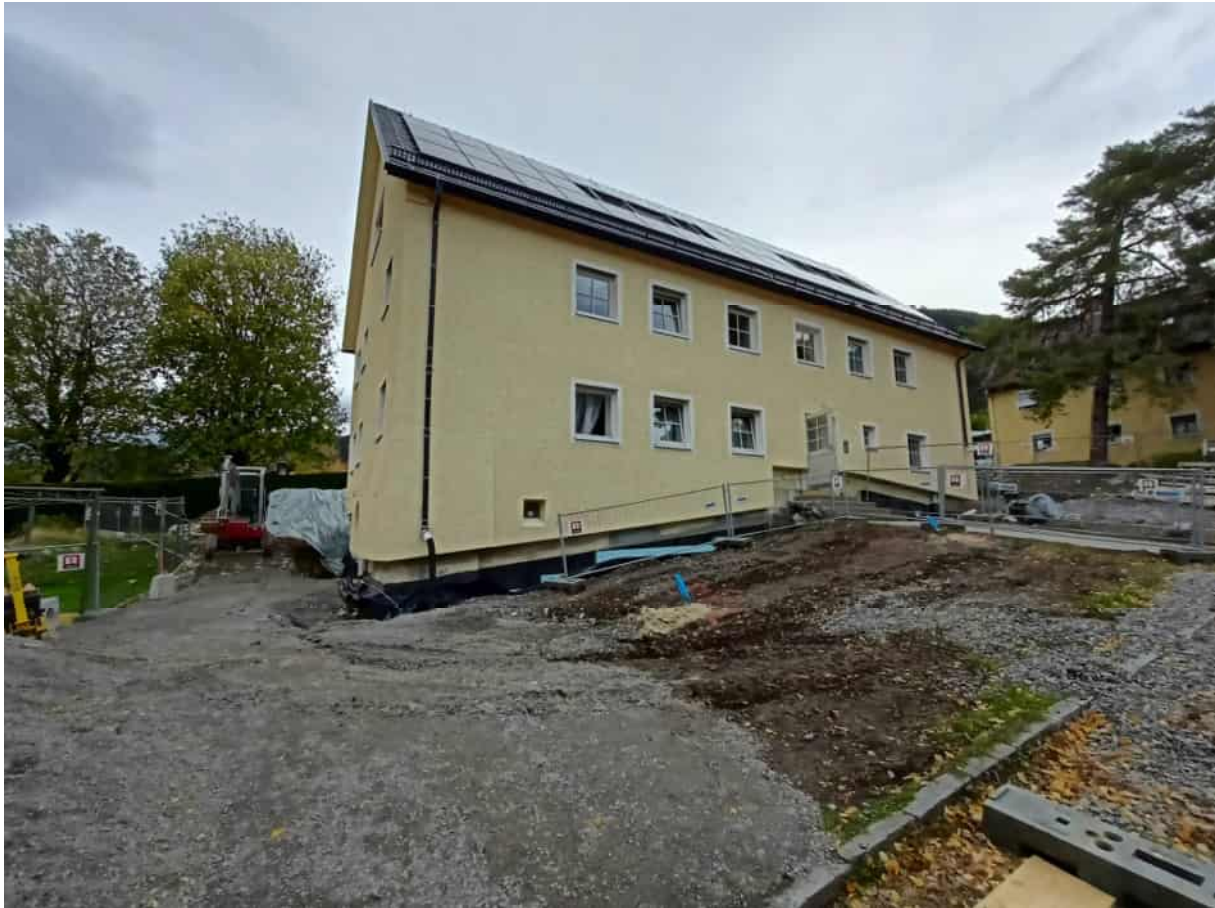
Abbildung 204: Geländemodellierung größeres Gebäude; Foto Rhomberg Bau GmbH
