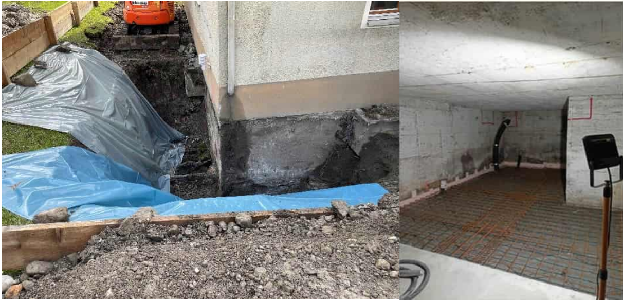
Abbildung 9: Freilegung der Kelleraußenwand vor Abdichtung und Dämmung; neuer Kellerfußboden, großes Gebäude; Fotos Rhomberg Bau GmbH
