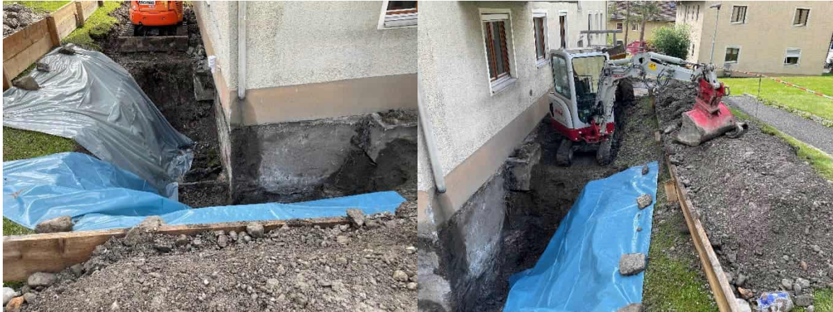
Abbildung 96: Aufgraben der Kelleraußenwände – großes Gebäude; Fotos: Rhomberg Bau GmbH
