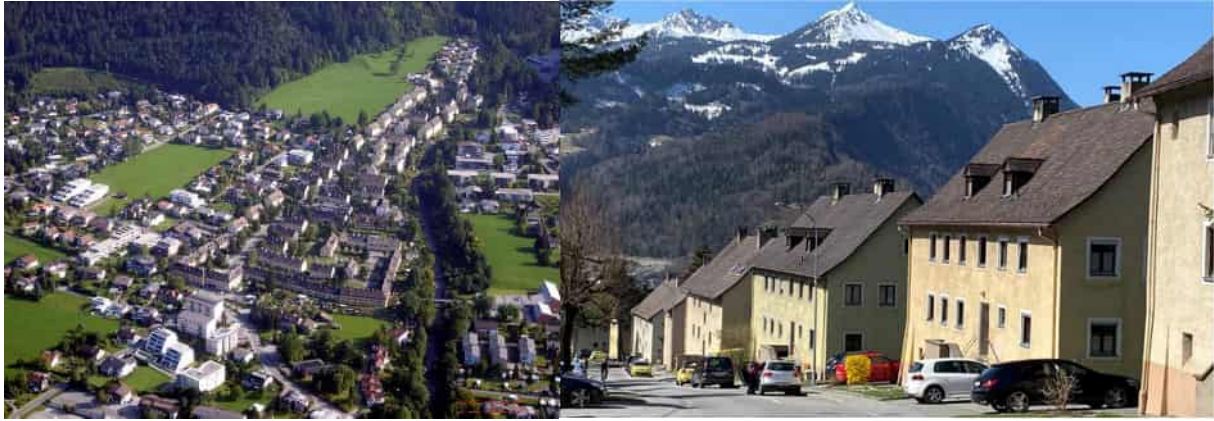
Abbildung 24: Luftbild der Siedlung (Quelle: https://pid.volare.vorarlberg.at/o:116498 ); Teilansicht St. Antoniusstraße (Foto: Energieinstitut Vorarlberg)
