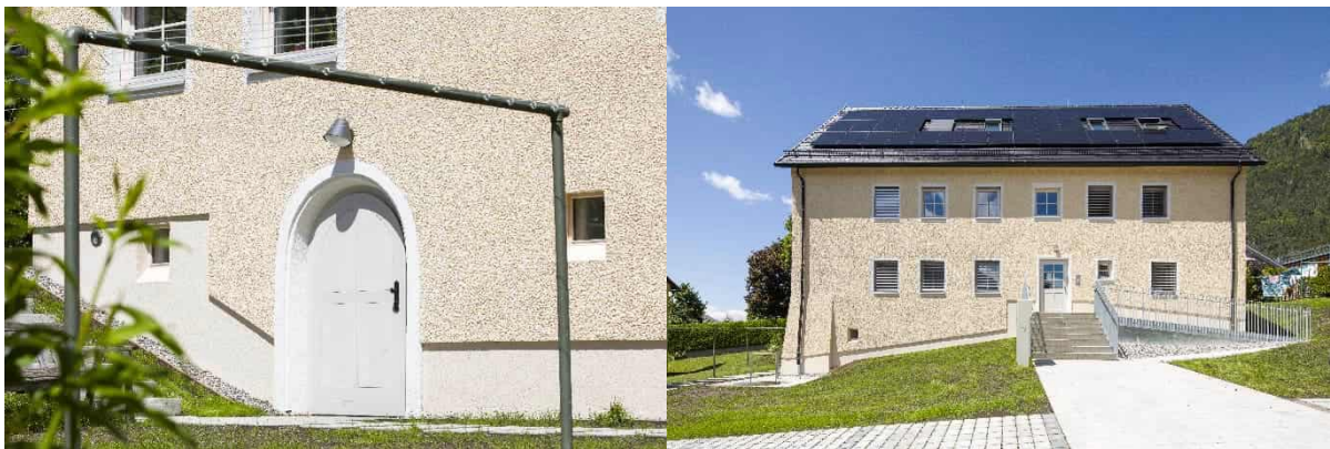
Abbildung 150: Kleines Gebäude nach Sanierung; Fotos: Walser Fotografie, Hohenems
