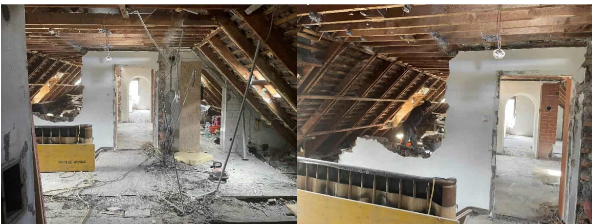
Abbildung 168: kleines Gebäude: Abbruch Dachgeschoß, Fotos: Rhomberg Bau GmbH
