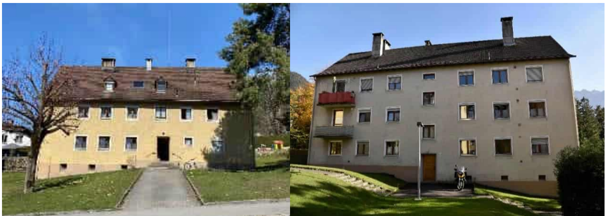
Abbildung 25: Kleines und großes Gebäude; Fotos: Energieinstitut - links, Johannes Kaufmann und Partner GmbH - rechts
