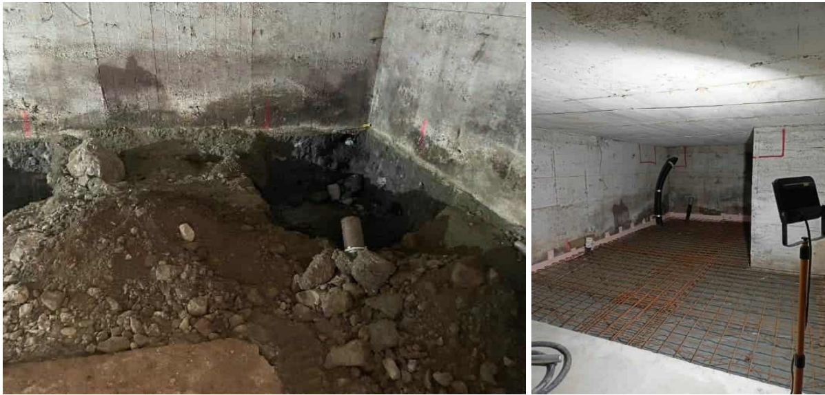
Abbildung 104: Arbeiten am Kellerboden; Fotos: Fotos: Rhomberg Bau GmbH
