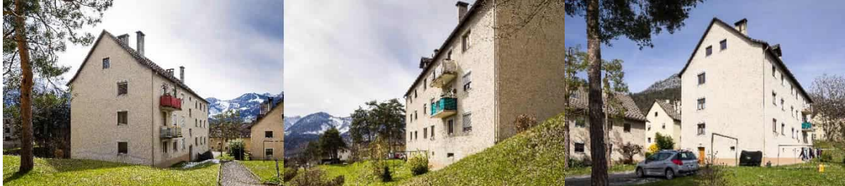
Abbildung 33: großes Gebäude, Außenansichten (Fotos: Walser Fotografie, Hohenems)
