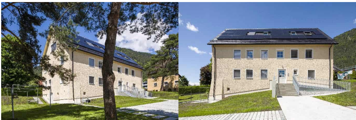
Abbildung 8: kleines Gebäude nach der Sanierung; Johannes Kaufmann und Partner GmbH; Fotos: Walser Fotografie, Hohenems
