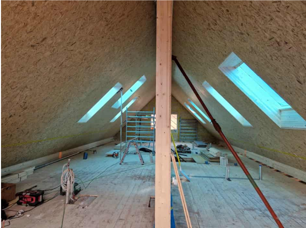
Abbildung 180: kleines Gebäude: neues Dachgeschoß; Foto: Rhomberg Bau GmbH
