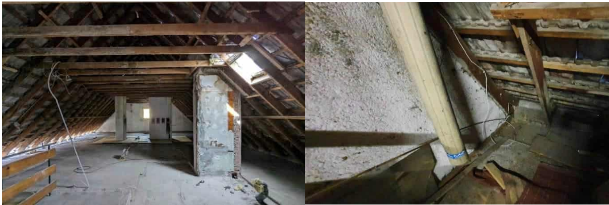
Abbildung 51: Dachstuhl großes Gebäude, Fotos: Energieinstitut Vorarlberg (links), Rhomberg Bau GmbH
