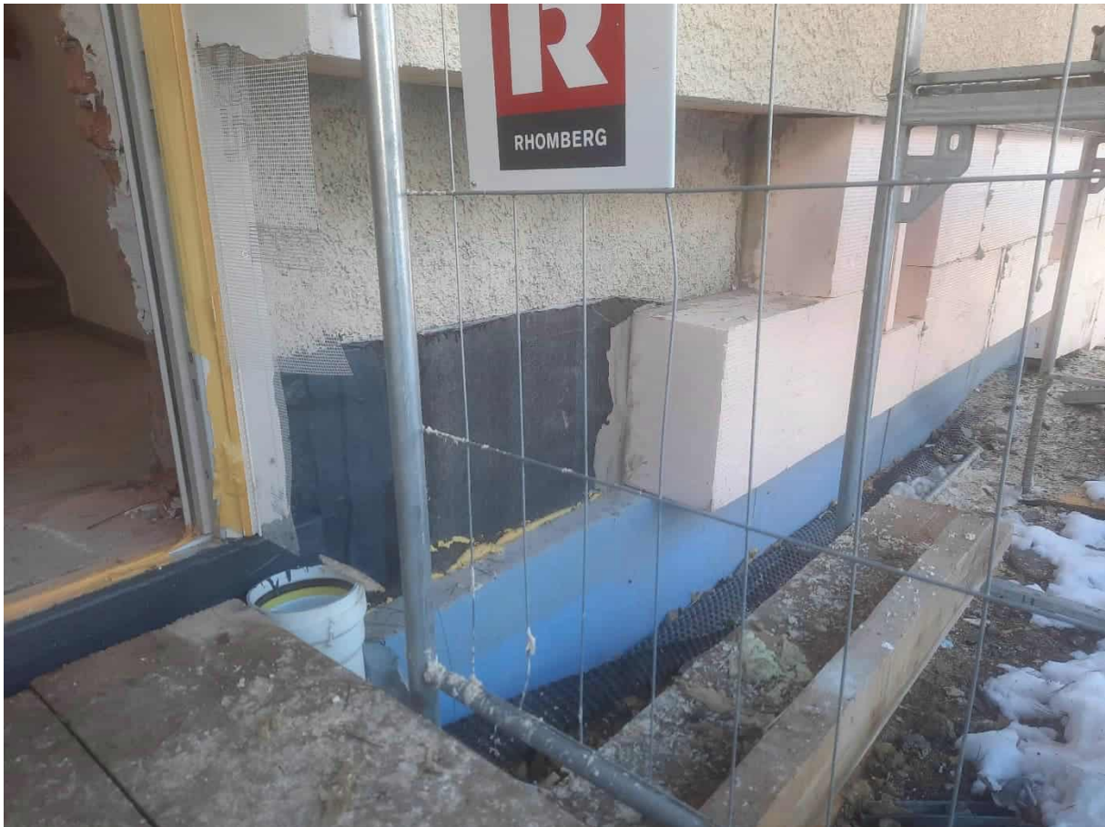
Abbildung 100: Verfüllung mit Schotter; verstärkte Dämmung im Sockelbereich; Foto: Rhomberg Bau GmbH
