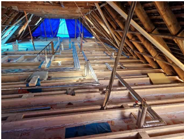
Abbildung 191: kleines Gebäude: Nutzung der obersten Geschoßdecke zur Horizontalverteilung, Fotos: Rhomberg Bau GmbH
