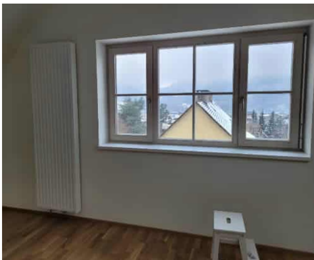
Abbildung 192: Niedertemperatur-Heizkörper im DG des kleinen Gebäudes; Energieinstitut Vorarlberg
