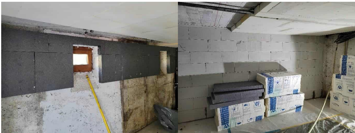
Abbildung 101: Flankendämmung im oberen Bereich der Außenwand KG; Dämmung der Kellerdecke, Fotos: Rhomberg Bau GmbH
