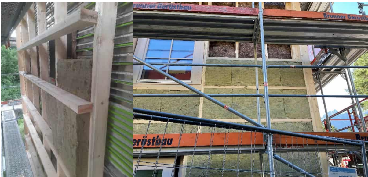
Abbildung 112: großes Gebäude: erste und zweite Lage Mineralwolldämmung; Fotos: Energieinstitut Vorarlberg
