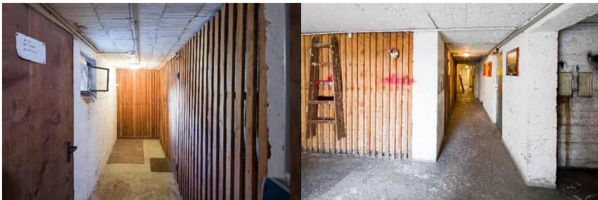
Abbildung 43: Keller im kleinen (links) und im großen Gebäude (Fotos: Walser Fotografie, Hohenems)
