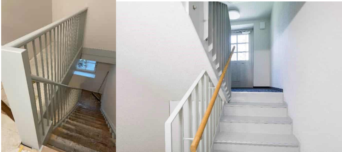
Abbildung 183: kleines Gebäude: Treppenhaus vor und nach Sanierung, Fotos: Rhomberg Bau GmbH (links); Walser Fotografie
