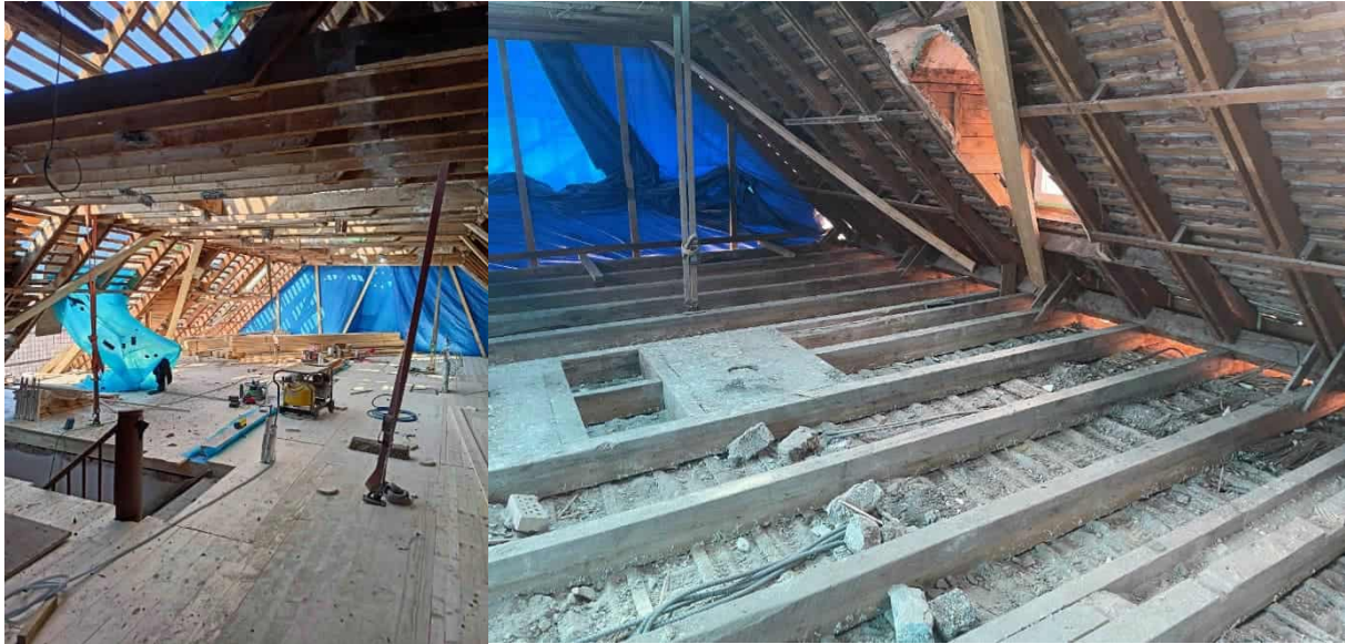
Abbildung 169: kleines Gebäude: Dachgeschoß nach Abbruch der Innen- und Giebelwand, oberste Geschoßdecke offen; Foto: Rhomberg Bau GmbH
