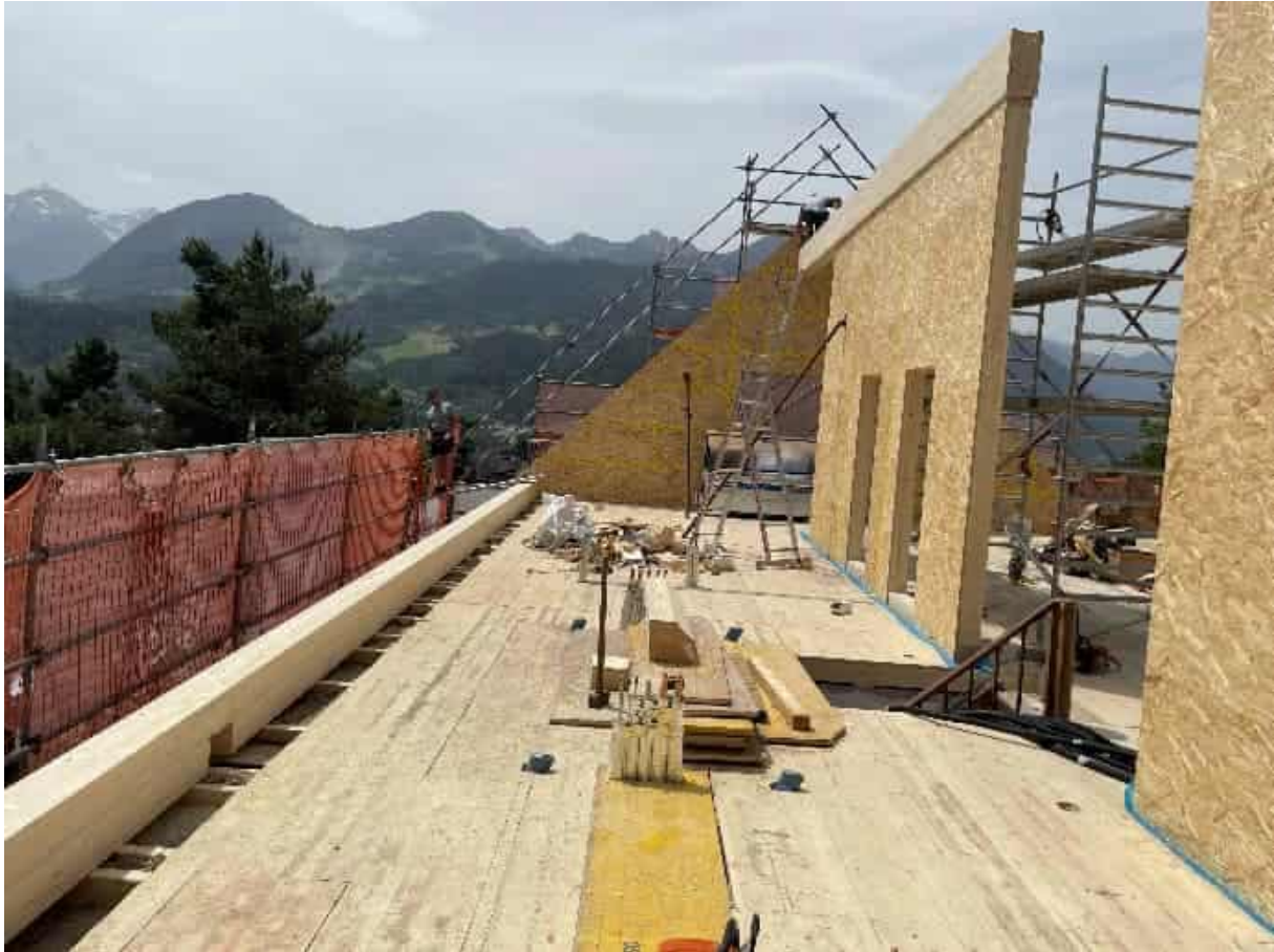
Abbildung 176: kleines Gebäude: DG nach Schließen der obersten Geschoßdecke und Montage der Giebelwand und der tragenden Innenwand; Foto: Rhomberg Bau GmbH
