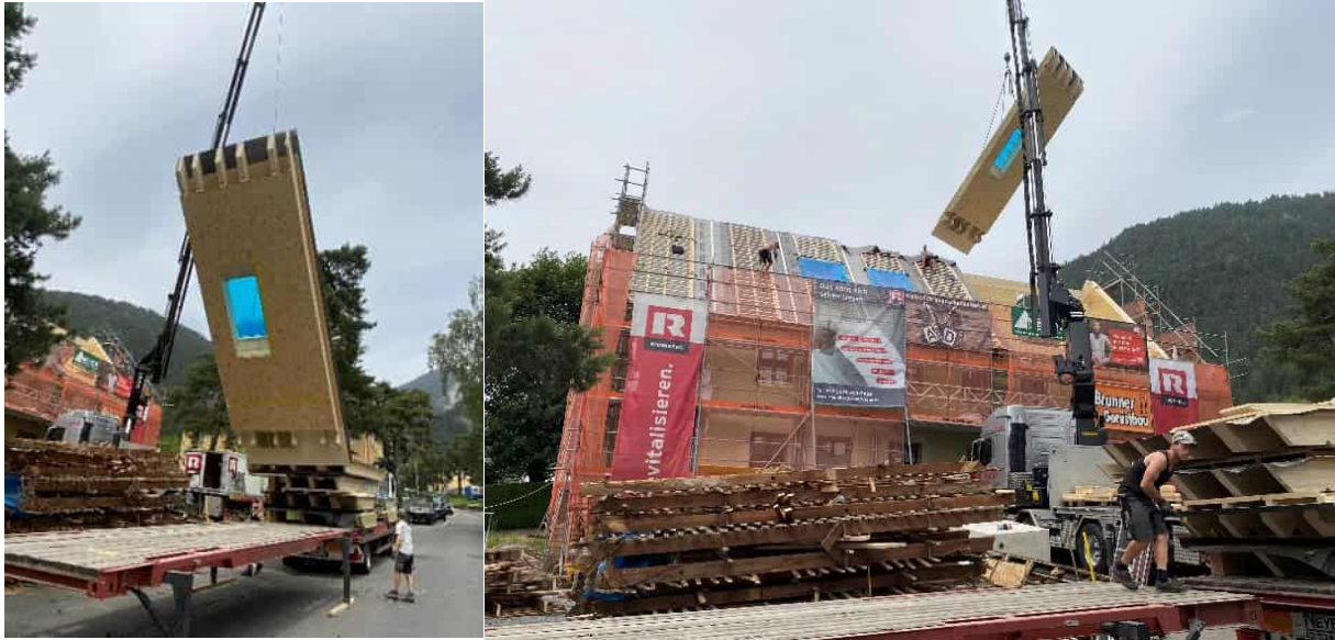
Abbildung 178: kleines Gebäude: Montage der vorgefertigten Dachelemente, Fotos: Energieinstitut Vorarlberg
