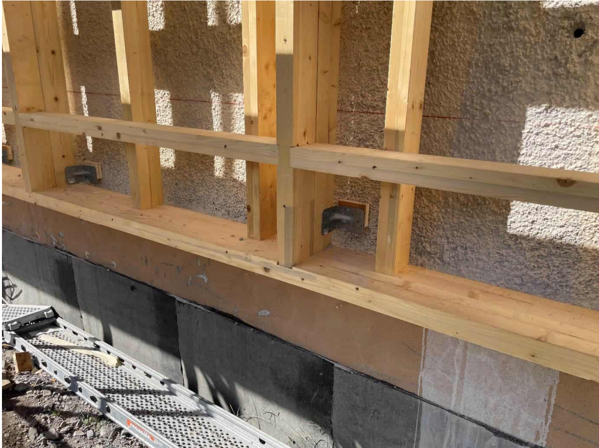
Abbildung 111: großes Gebäude: teil-vorgefertigte Kreuzlagenelemente; Foto: Energieinstitut Vorarlberg
