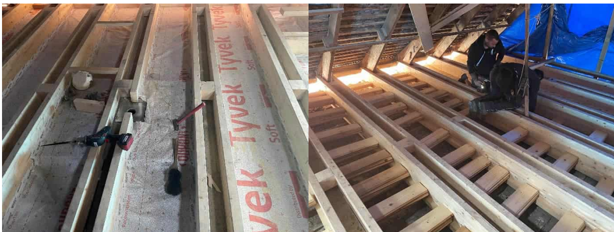
Abbildung 170: kleines Gebäude: Verstärkung der obersten Geschoßdecke, Foto: Rhomberg Bau GmbH
