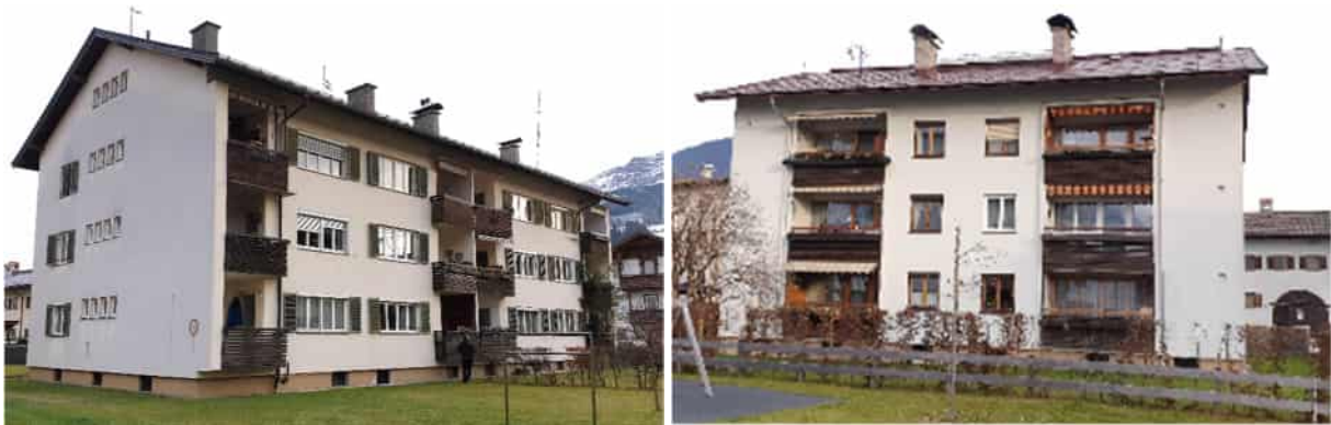
Abbildung 211: gemeinnütziger Wohnbau St. Johann vor der (geplanten) umfassenden Sanierung; Fotos: Neue Heimat Tirol
