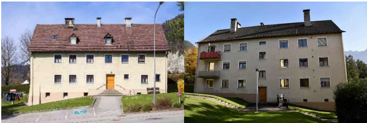
Abbildung 1: kleines und großes Gebäude vor Sanierung; Fotos: Walser Fotografie, Hohenems, M. Fortenbacher
