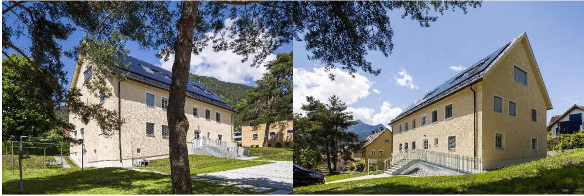
Abbildung 149: Kleines Gebäude nach Sanierung; Fotos: Walser Fotografie, Hohenems
