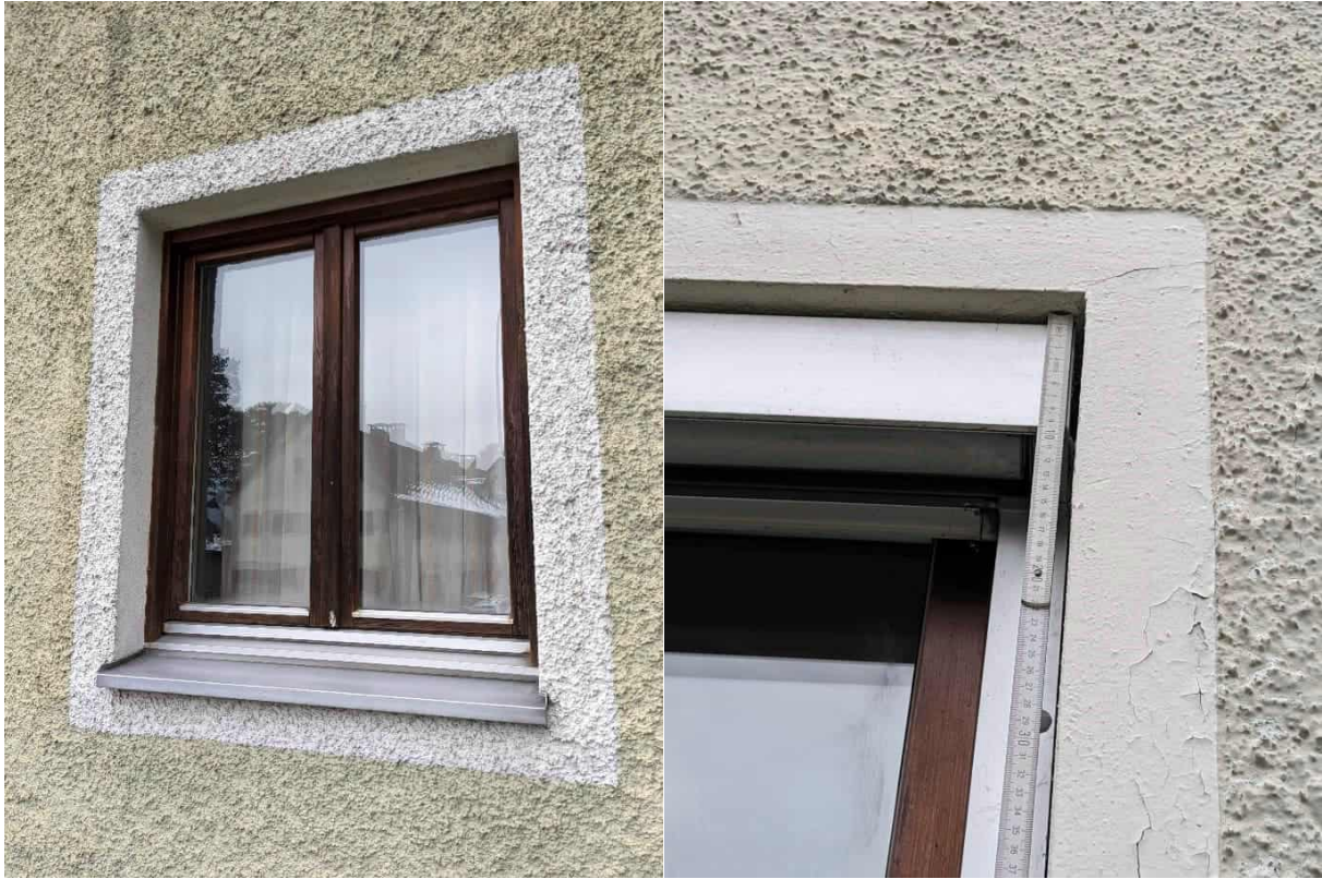
Abbildung 48: Fenster ohne außenliegenden Sonnenschutz im kleinen Gebäude – links, Foto: Energieinstitut Vorarlberg und mit Sonnenschutz im großen Gebäude, Foto: Rhomberg Bau GmbH
