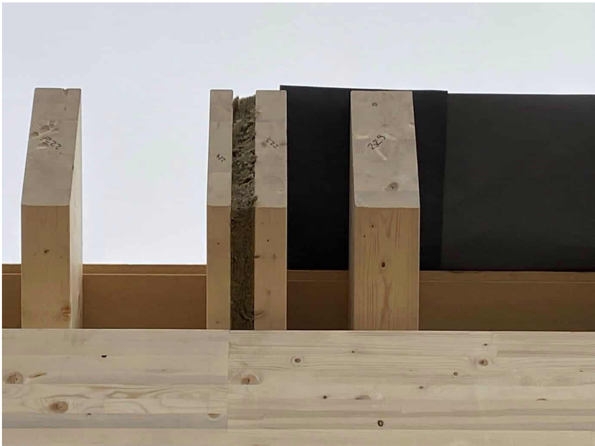
Abbildung 179: kleines Gebäude: Stoß der vorgefertigten Dachelemente, Foto: Rhomberg Bau GmbH
