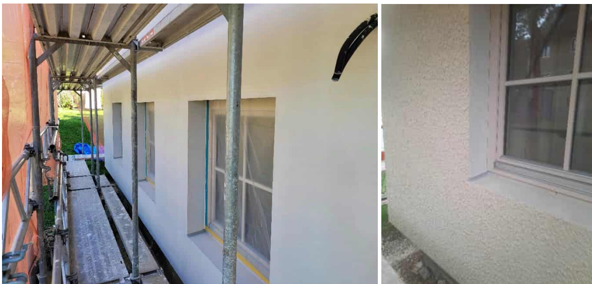
Abbildung 165: kleines Gebäude: Grund- und Feinputz, Fotos: Energieinstitut Vorarlberg
