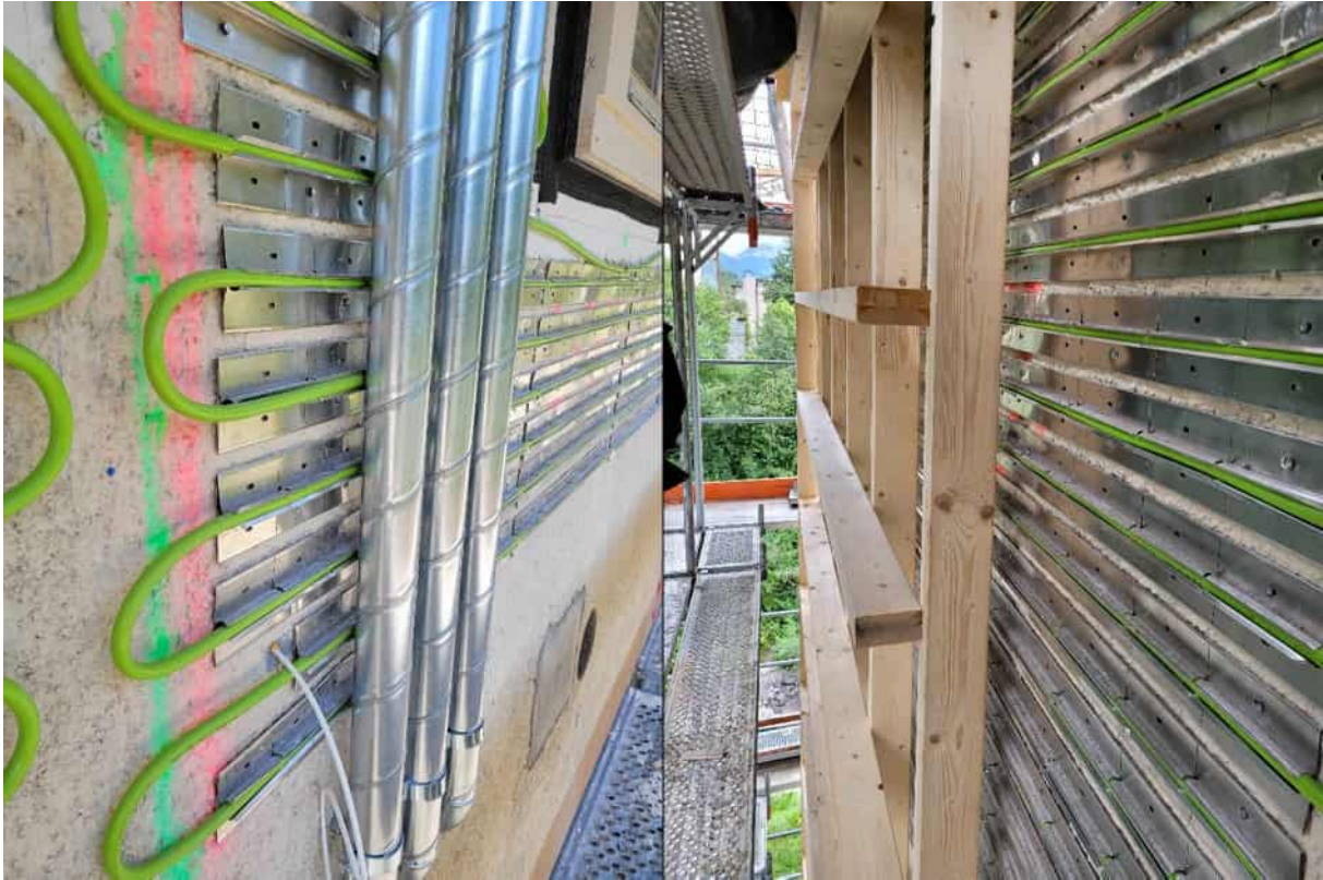
Abbildung 109: großes Gebäude: Wandheizelemente und Zuluftrohre – links; vorgefertigte Kreuzlagenelemente; Fotos: Energieinstitut Vorarlberg
