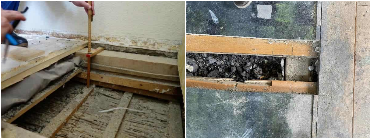
Abbildung 49: kleines Gebäude: Geschoßdecke zwischen den Wohnungen, Fotos: Energieinstitut Vorarlberg
