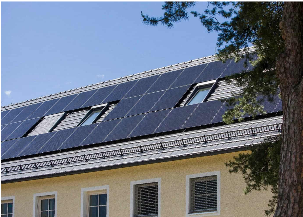
Abbildung 199: PV-Anlage kleines Gebäude; Fotos: Rhomberg Bau GmbH
