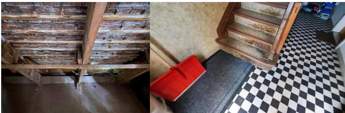
Abbildung 5: Dachkonstruktion und -deckung sowie Treppenhaus im kleinen Gebäude; Fotos: Energieinstitut Vorarlberg (links), Rhomberg Bau GmbH
