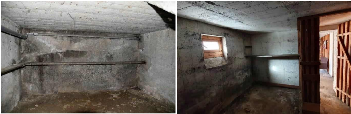
Abbildung 41: Kellerboden im großen Gebäude – links und im kleinen Gebäude, Fotos: Rhomberg Bau GmbH
