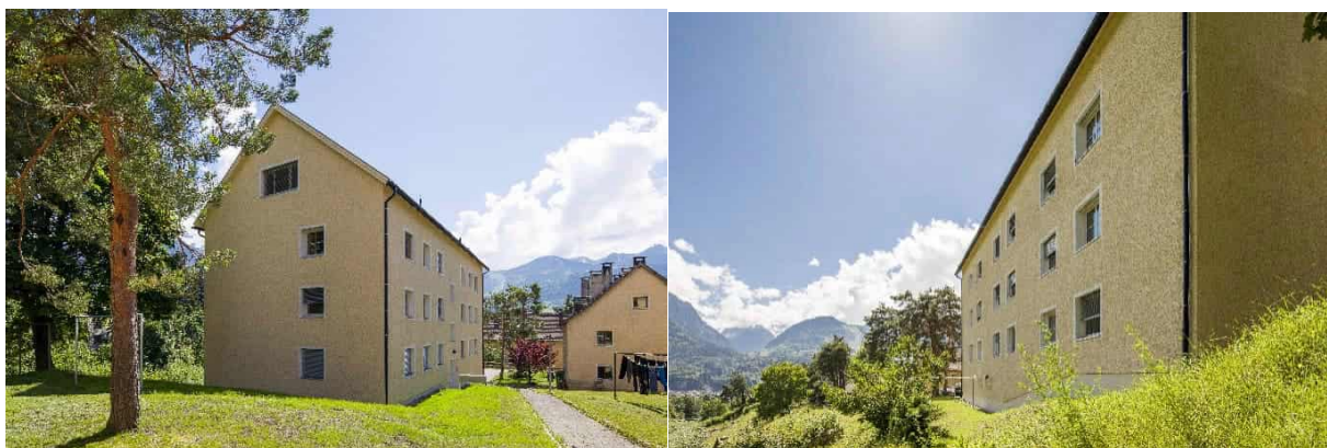
Abbildung 82: großes Gebäude nach Sanierung; Fotos: Walser Fotografie, Hohenems
