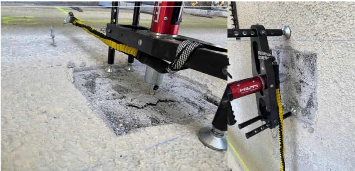
Abbildung 47: Dübelausziehversuche an der Außenwand des größeren Gebäudes; Fotos: Rhomberg Bau GmbH
