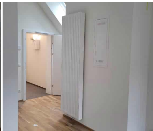
Abbildung 192: Niedertemperatur-Heizkörper im DG des kleinen Gebäudes; Energieinstitut Vorarlberg
