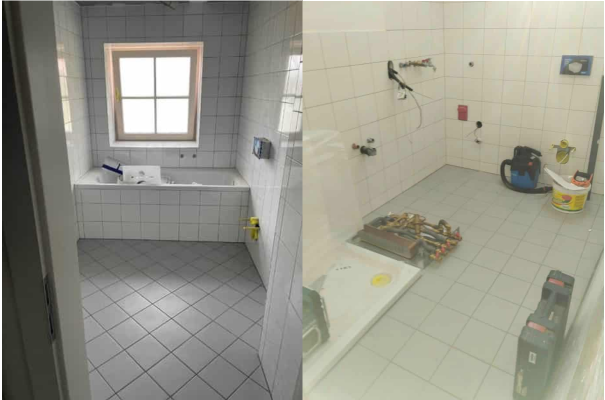
Abbildung 203: Modernisiertes Bad und neues Bad im DG des kleinen Gebäudes; Foto: Rhomberg Bau GmbH
