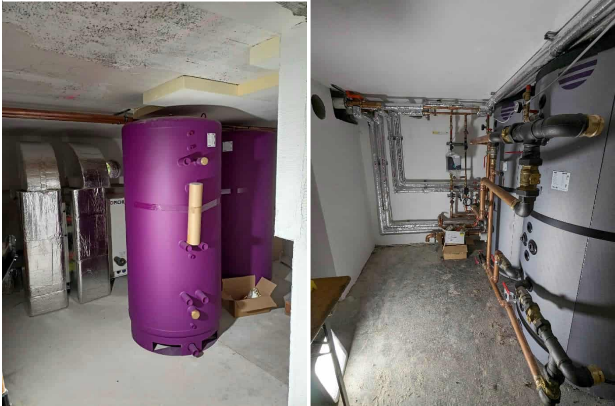
Abbildung 126: Schichtenspeicher ohne Dämmung und im eingebauten Zustand; Fotos: Rhomberg Bau GmbH (links), Johannes Kaufmann und Partner GmbH
