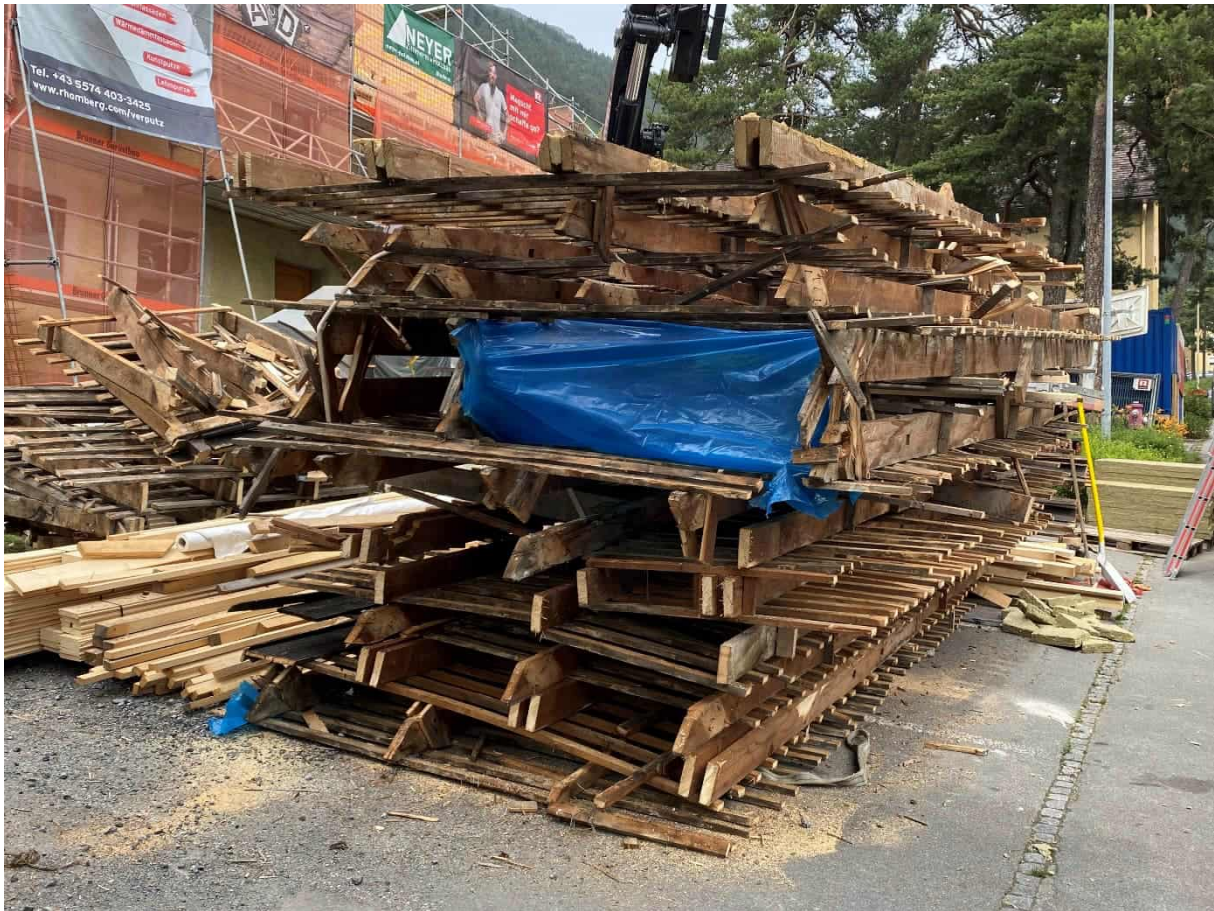
Abbildung 174: kleines Gebäude: Bestandsdachstuhl nach Ausbau, Foto: Energieinstitut Vorarlberg
