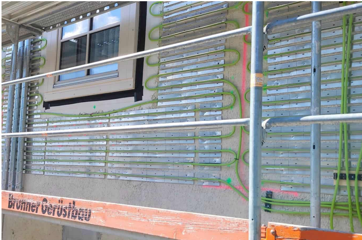
Abbildung 117: abgeklebte Fenster und Wandheizelemente; Foto: Rhomberg Bau GmbH
