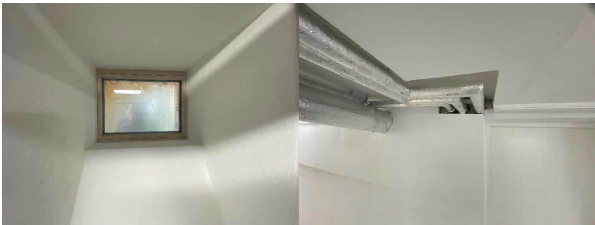
Abbildung 105: Neue Kellerfenster und Leitungsführung unter der Kellerdeckendämmung bzw. in der Dämmebene; Fotos: Energieinstitut Vorarlberg
