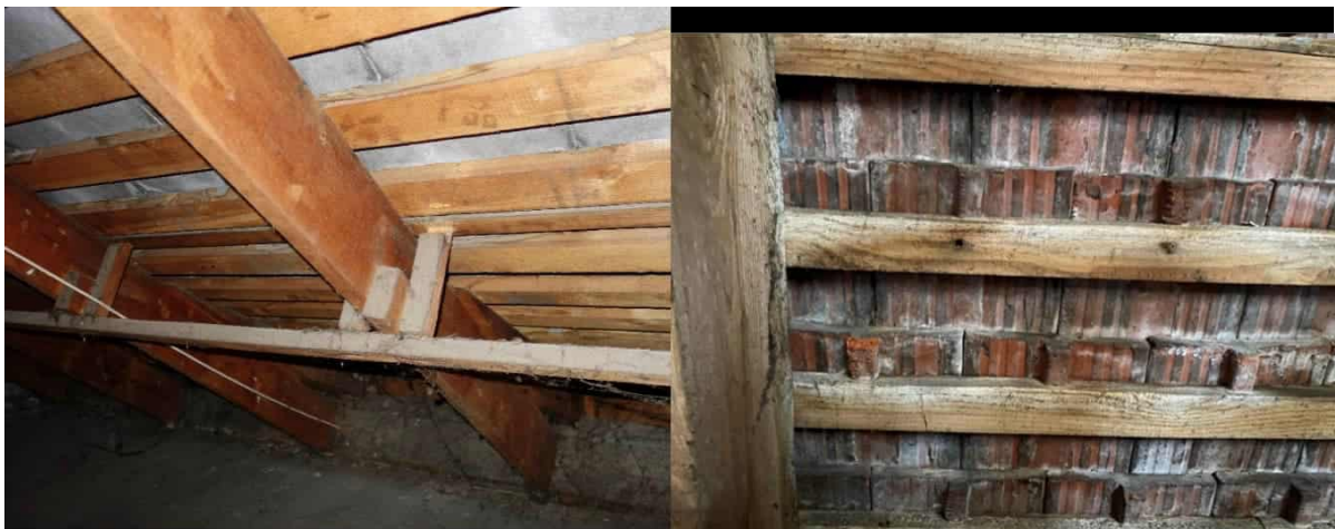
Abbildung 52: Dachstuhl großes Gebäude, Fotos: Energieinstitut Vorarlberg (links), Rhomberg Bau GmbH
