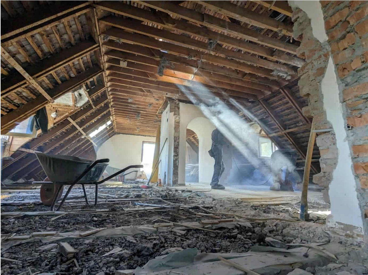
Abbildung 167: kleines Gebäude: oberste Geschoßdecke und Dachstuhl, Foto: Johannes Kaufmann und Partner GmbH
