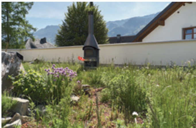
Betriebsgebäude mit Wohnung/Altach begehbare Gründach, extensive Begrünung Fertigstellung 2020
