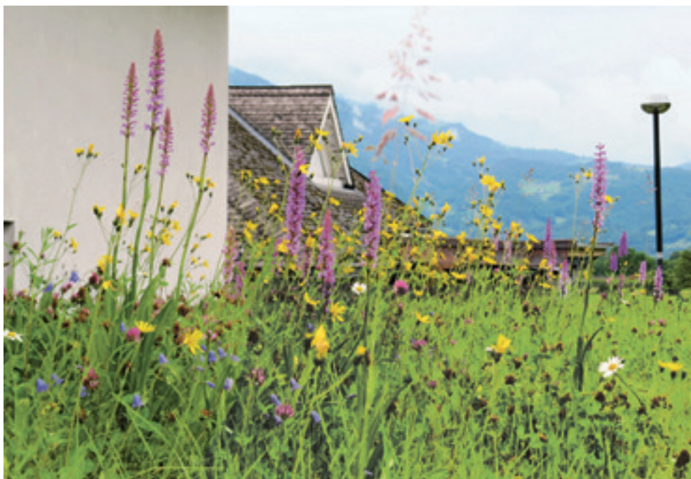
Orchideendach auf Carport und Schuppen/Rankweil Eigenbau, extensive Begrünung Fertigstellung ca. 2000
