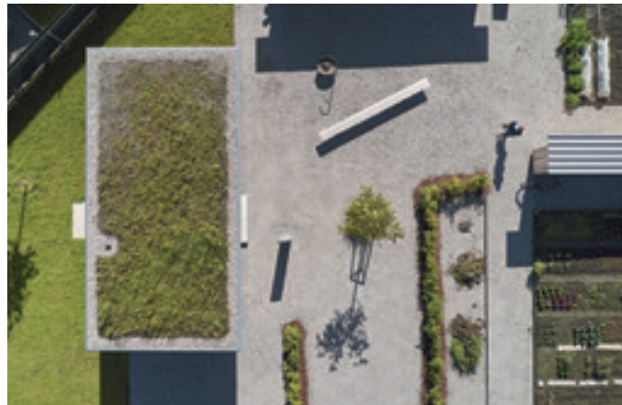
Gemeinschaftshaus in Niederbahn (Neubau)/Dornbirn nicht begehbar, extensive Begrünung Fertigstellung 2020
