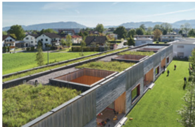
Kindergarten Am Schlatt/Lustenau nicht begehbare Gründach, extensive Begrünung Fertigstellung 2020
