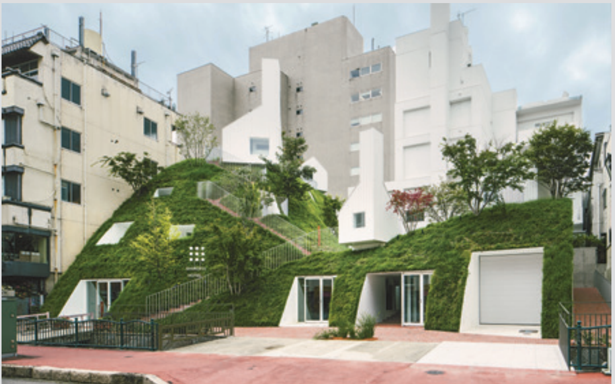
Hotelerweiterung von Sou Fujimoto Architects bei Tokio mit grasbewachsenem Hügel.
