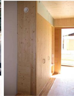
**Schlanke Gebäudehülle in Ständerbau sichtbare Massivholzdecken bei Bedarf massive tragende Wände**
