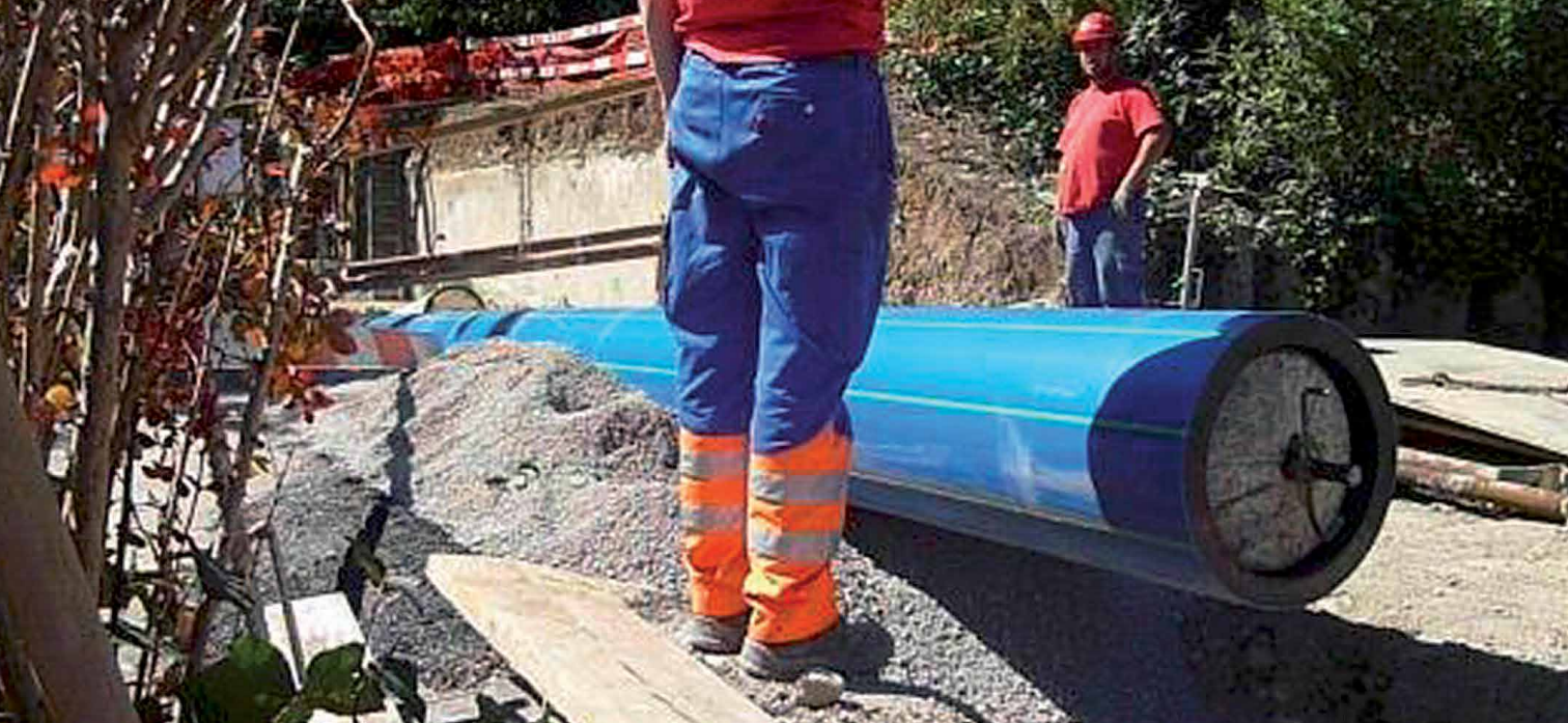
» Abwärmenutzung durch Anergie-Netze, Foto: Amstein & Walther
