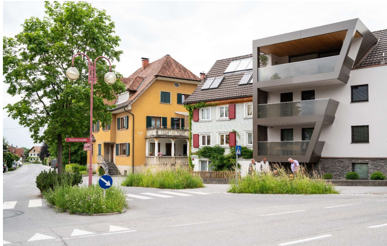
Abbildung 10 Querungshilfe in der Gemeinde Sulz © Alexandra Serra
