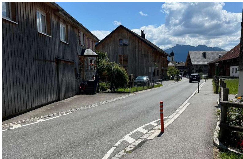
Abbildung 17 Poller als Schutzmaßnahme für Fußgänger*innen © Energieinstitut Vorarlberg
