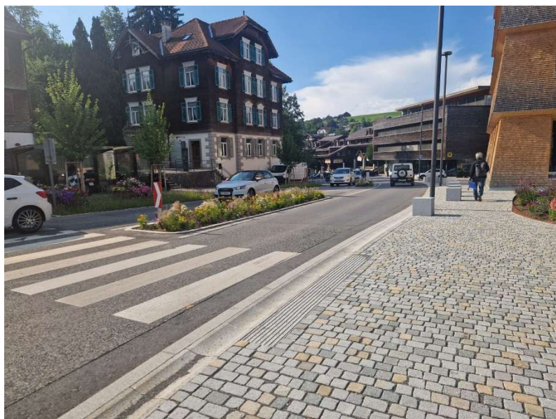
Abbildung 15 Maßnahmen im Mischverkehr mit Temporeduktion, Mittelinsel, Schutzweg, Bereich für Fußgänger*innen sowie ein Materialwechsel © Marktgemeinde Egg
