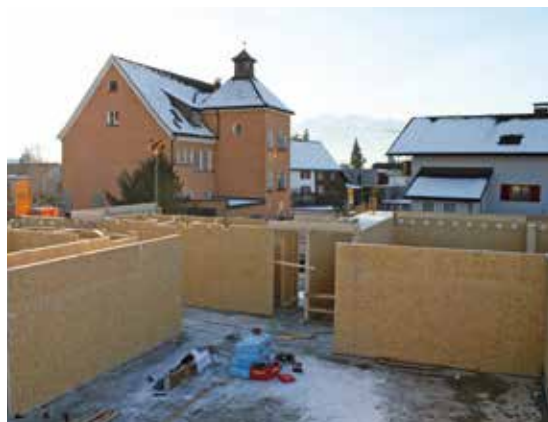
Baufortschritt Kindergarten Muntlix
