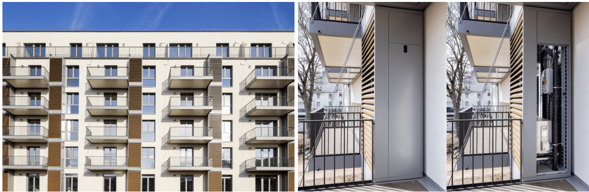
Abbildung 6: Ansicht der Modullösung von Vivaero zur Integration von Multi-Split-Wärmepumpen (Quelle: [18])
