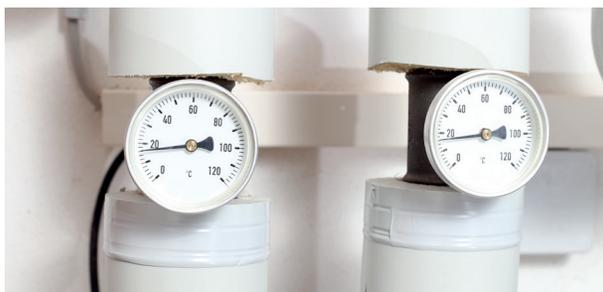
» Wärmedämmung bei Heizverteillrohren.
