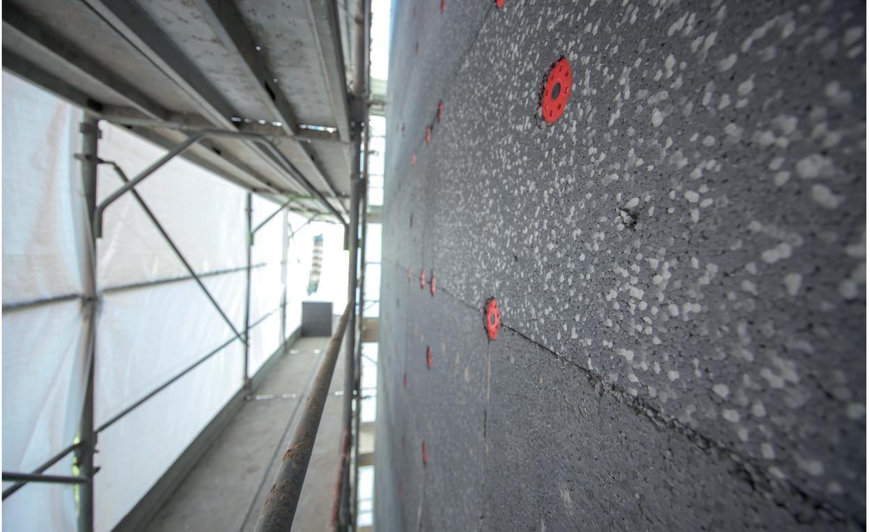
» Wärmedämmverbundsystem aus EPS-Dämmplatten und Kunststoffverdübelung.
