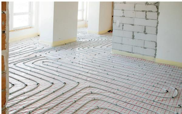
» PE- Kunststoffolie als Dampfsperre mit Heizleitungen vor dem Estricheinbau
