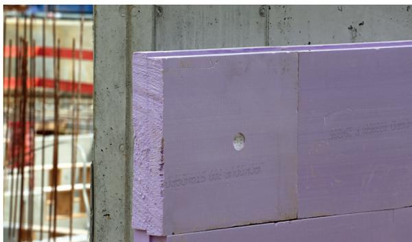
» Kelleraußenwand mit XPS-Wärmedämmung
