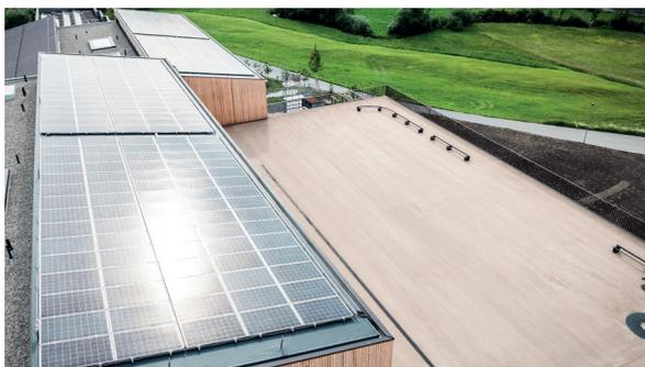
Eine Photovoltaik-Anlage auf dem Dach mit 90 kWp Leistung liefert Sonnenstrom, die Regenwasserzisterne untertage spart 50 Prozent Trinkwasser ein.
