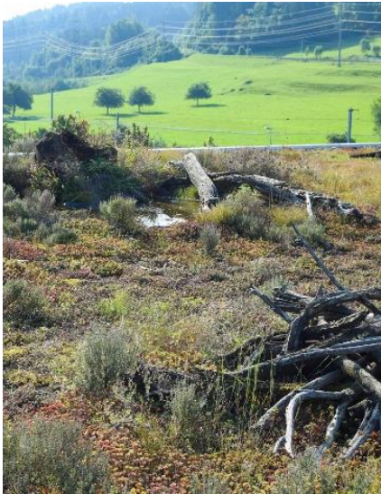
Gründach mit Biodiversitätselementen Migros Verteilerzentrum, Gossau CH (© pulswerk)
