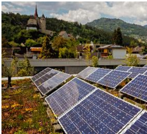
Grün- mit Photovoltaikdach Haus Klosterreben, Rankweil (© Pulswerk)
