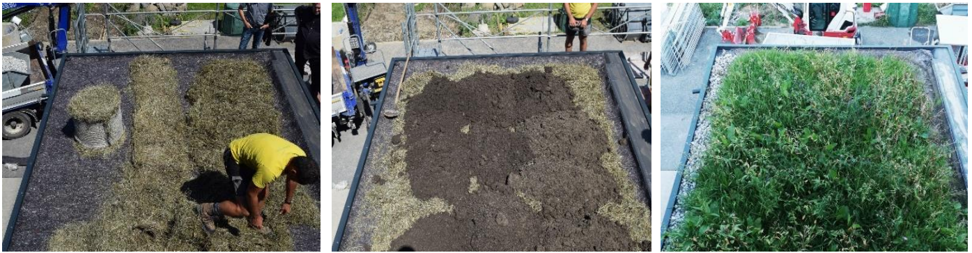
Begrünung eines Stalldachs; links: Aufbringung Stroh auf Schutzvlies auf Stallgebäude, mitte: ca. 7 cm Erde auf Stroh verteilen und nach einer Woche ansäen, rechts: Begrünung nach 2 Monaten (© pulswerk).
