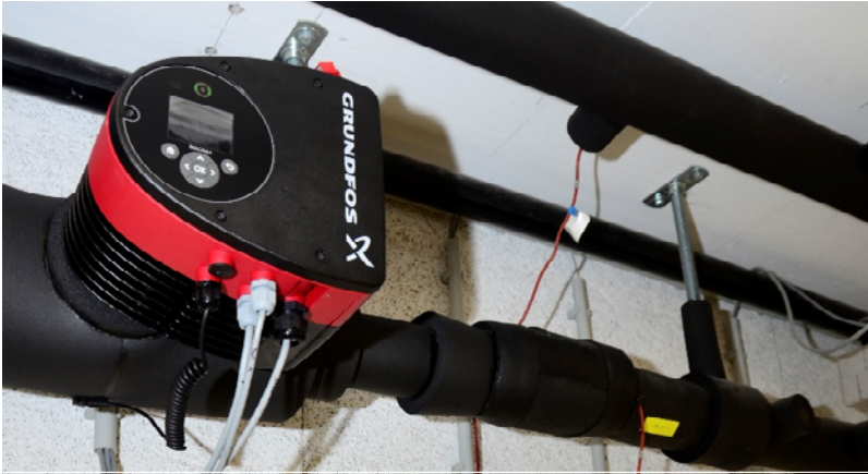
Abbildung 15: Solepumpe Grundfos Magna 3, 32-120 F.
