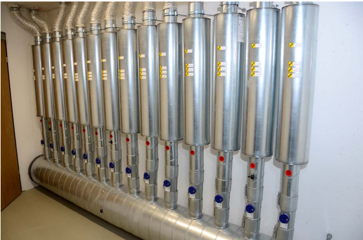
Abbildung 20: Sammelrohr und Einzelstränge mit Schalldämpfer und Konstantvolumenstromregler.
